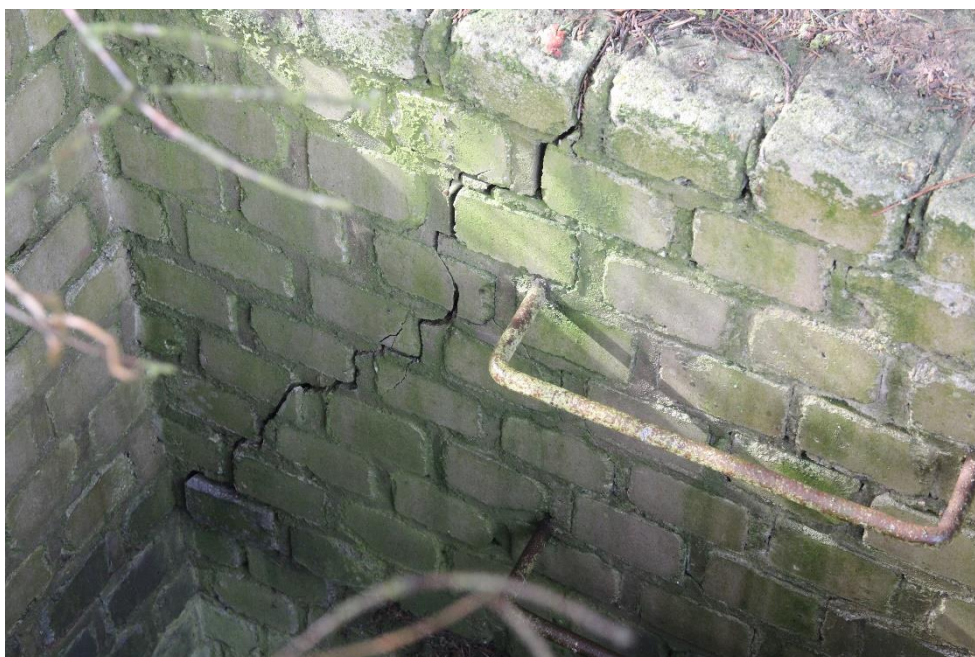
Trhlina ve zdivu se zasazuje, porušené spáry se opraví.
